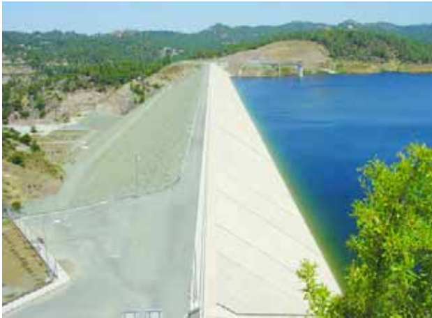
Το φράγμα Κανναβιούς σε λειτουργία
