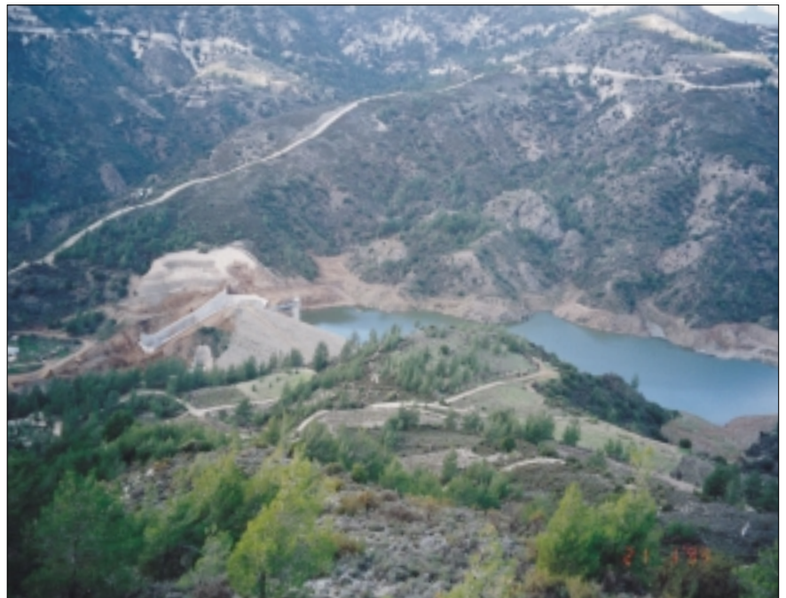
Πανοραμική άποψη φράγματος από Άγιο Νικόλαο - Panoramic view of dam from Ayios Nikolaos
