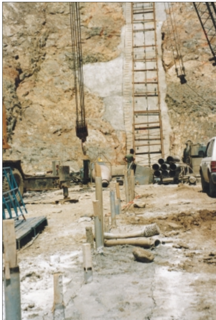
Διαφραγματικός τοίχος και τσιμεντενέσεις - Diaphragm wall and grouting pipes
