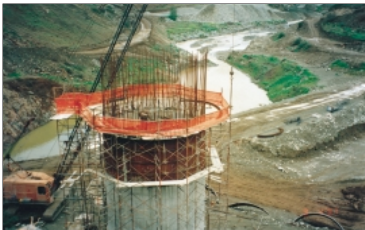
Πύργος υδροληψίας υπό κατασκευή - Intake tower under construction
