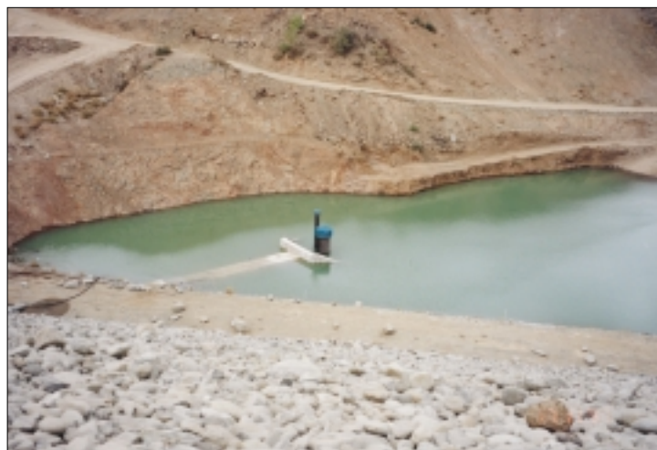
Σημείο υδροληψίας - Intake point
