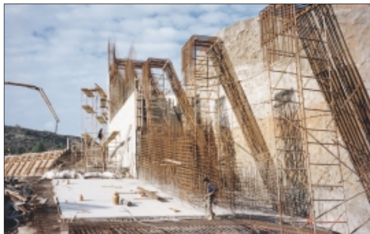
Υπερχειλιτής υπό κατασκευή - Spillway under construction
