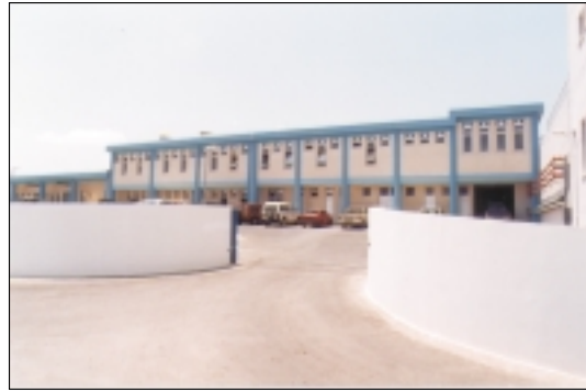
Κτίριο διοίκησης διυλιστηρίου νερού Τερσεφάνου
