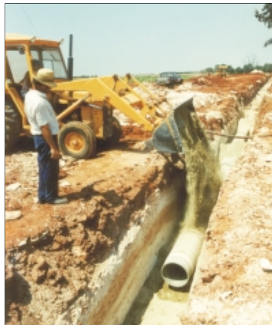
Τοποθέτηση αγωγού στα Κοκκινοχώρια
