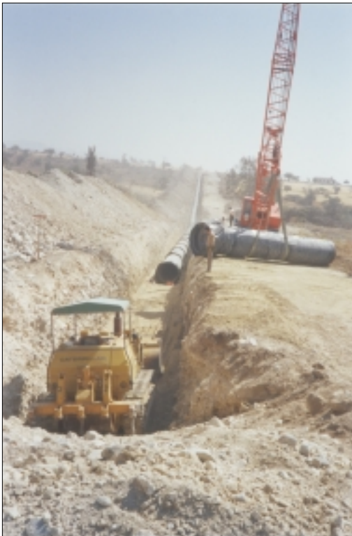
Τοποθέτηση κεντρικού αγωγού
