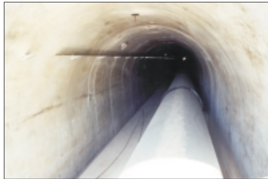
Τοποθέτηση κεντρικού αγωγού
