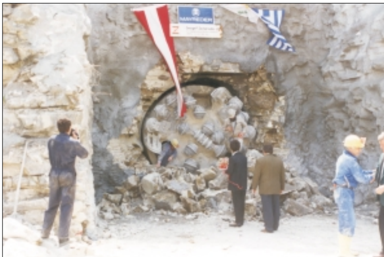
Σήραγγα εκτροπής Διάριζου
