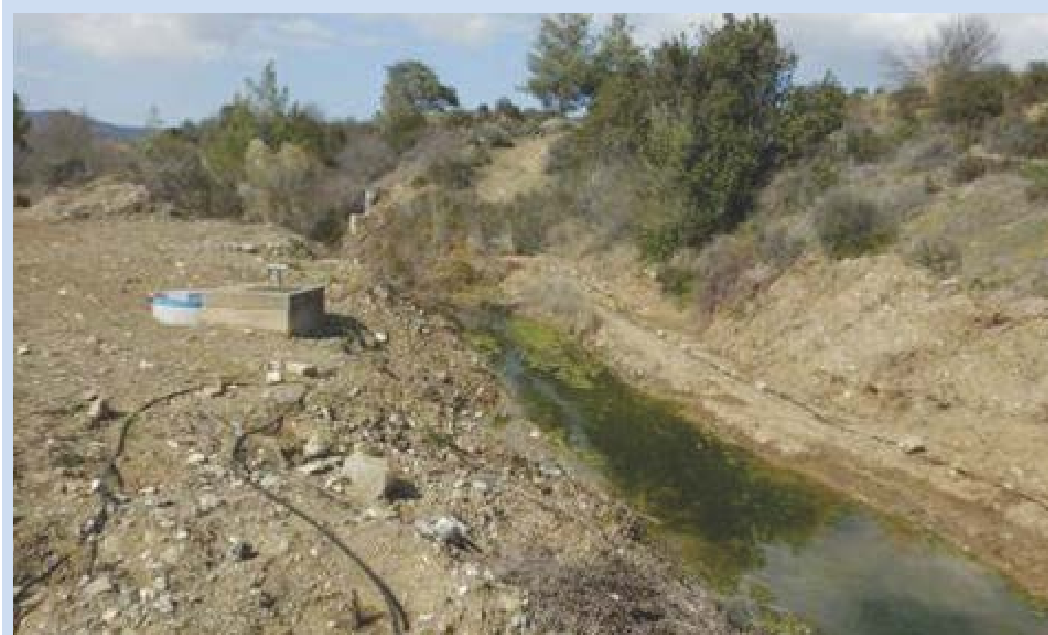
Αφαίρεση ξενικών ειδών, διαμόρφωση των όχθων, φυτεύσεις δενδρυλλίων και τοποθέτηση αρδευτικού συστήματος στα πρανή του ποταμού
