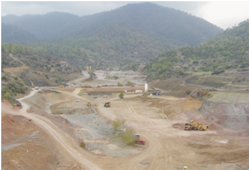
Κανναβιού (υπό κατασκευή)
