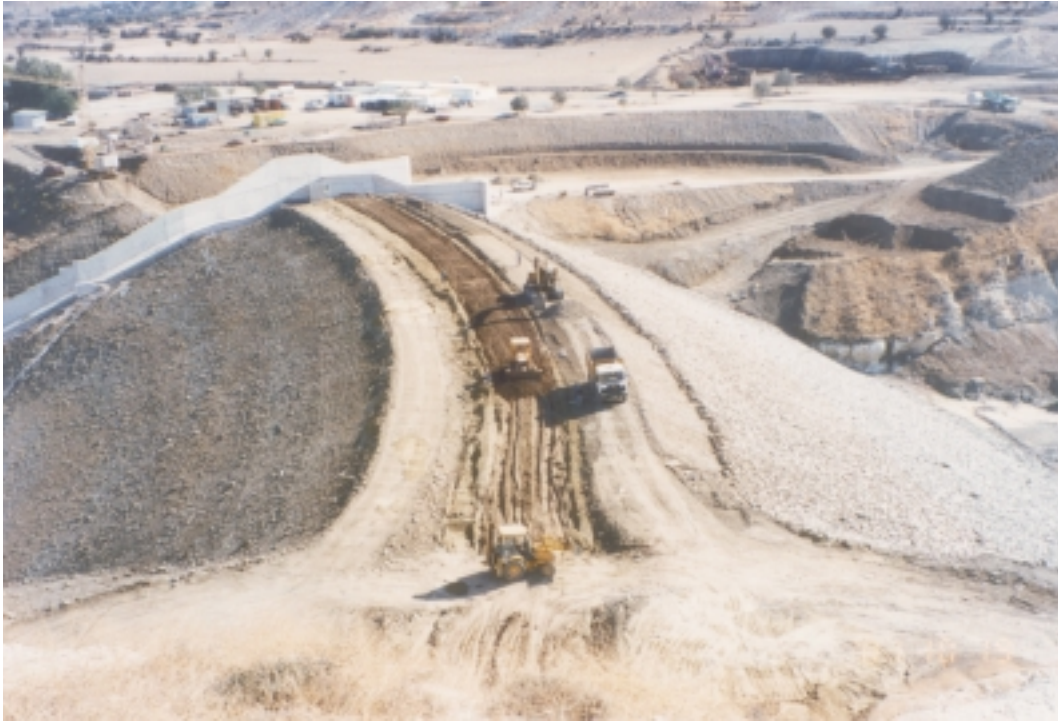
Ταμασός (υπό κατασκευή)
