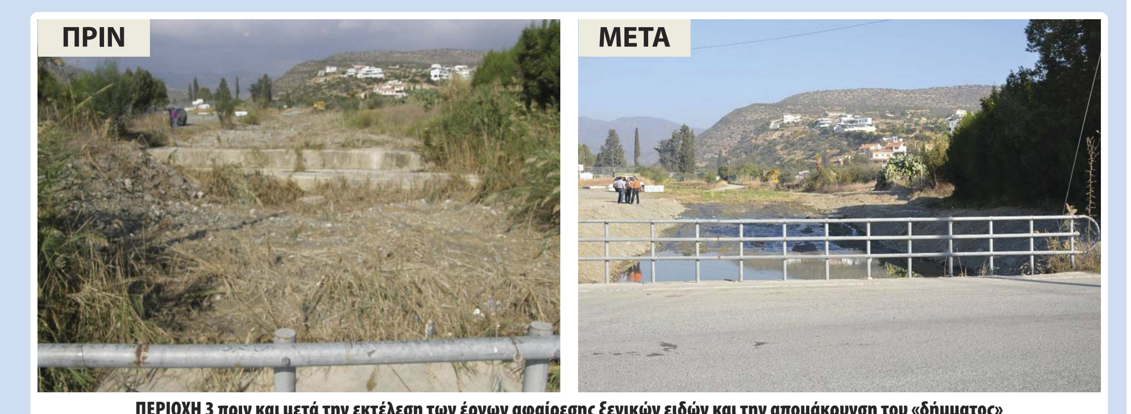
ΠΕΡΙΟΧΗ 3 πριν και μετά την εκτέλεση των έργων αφαίρεσης ξενικών ειδών και την απομάκρυνση του «δήματος»
