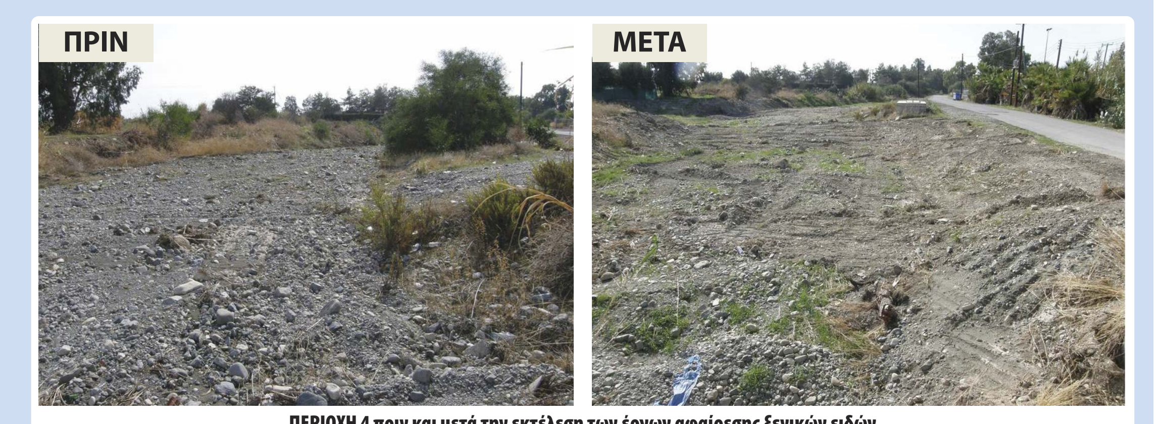
ΠΕΡΙΟΧΗ 4 πριν και μετά την εκτέλεση των έργων αφαίρεσης ξενικών ειδών
