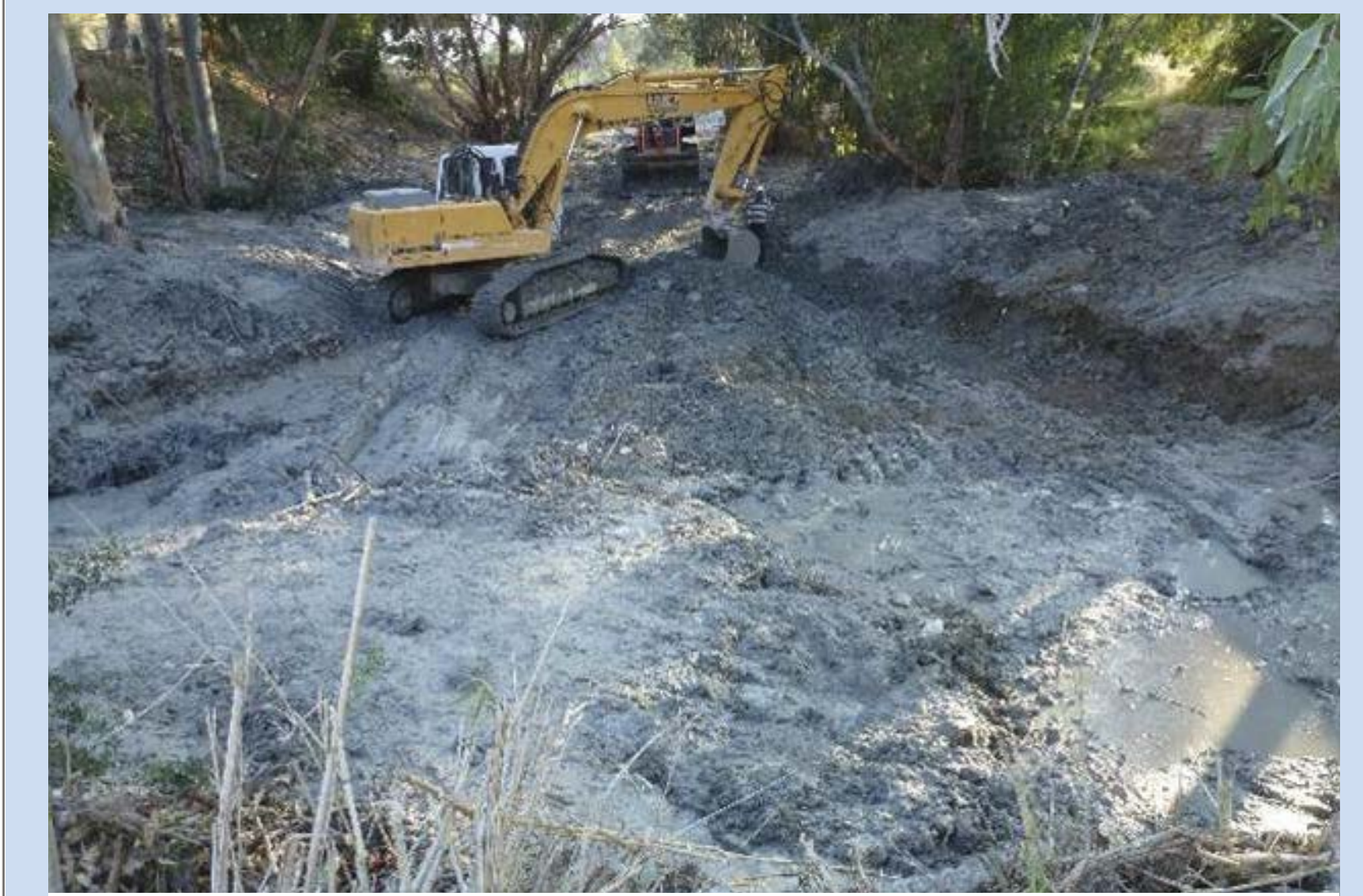
ΕΚΣΚΑΦΗ ΛΙΜΝΙΩΝ ΑΝΑΝΤΗ ΚΑΙ ΚΑΤΑΝΤΗ ΤΟΥ ΥΦΙΣΤΑΜΕΝΟΥ ΔΗΜΜΑΤΟΣ
