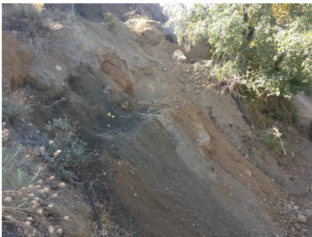
Εικόνα 2: Άποψη πρανών κατάντη οδογέφυρας, πριν και μετά τα έργα υδρομορφολογικής αποκατάστασης- Τμήμα 1 (Φώτο: I.A.CO Ltd).
