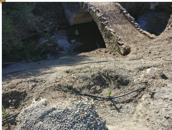
Εικόνα 1: Άποψη γεφυριού πριν και μετά τα έργα υδρομορφολογικής αποκατάστασης- Τμήμα 1 (Φώτο: Ι.Α.СО Ltd).
