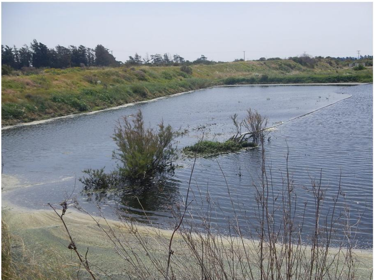
Φωτογραφία 2: Δεξαμενή 2 ή rr_9-6-9_A2a με απευθείας τροφοδοσία από τον αγωγό
