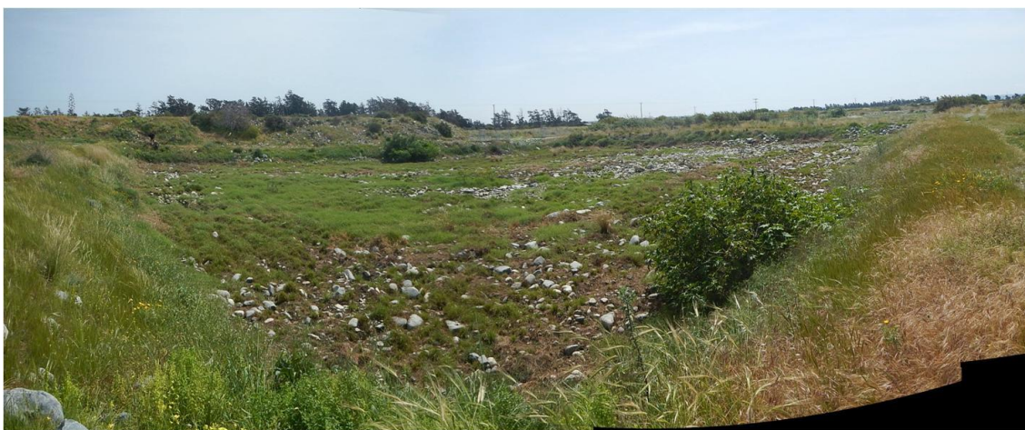
Φωτογραφία 6: Δεξαμενή rp_9-6-9_A2c, τροφοδοσία με υπερχειλίση από την rp_9-6-9_A2b
