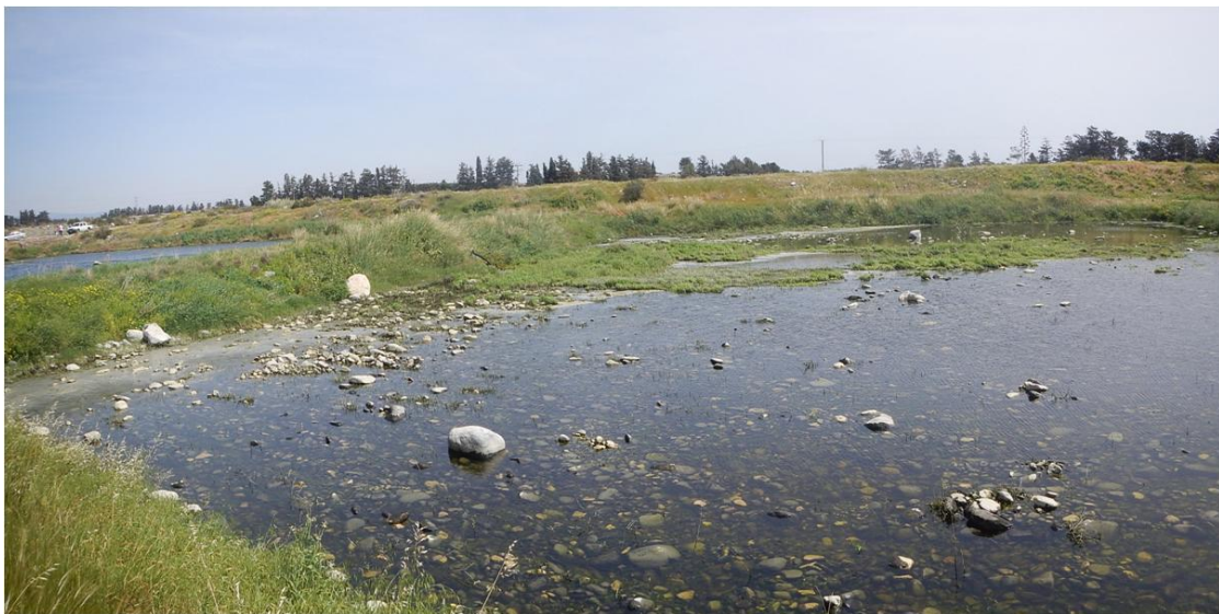
Φωτογραφία 5: Δεξαμενή rp_9-6-9_A2b που τροφοδοτείται με υπερχειλίση από την ανάντη δεξαμενή rp_9-6-9_A2a
