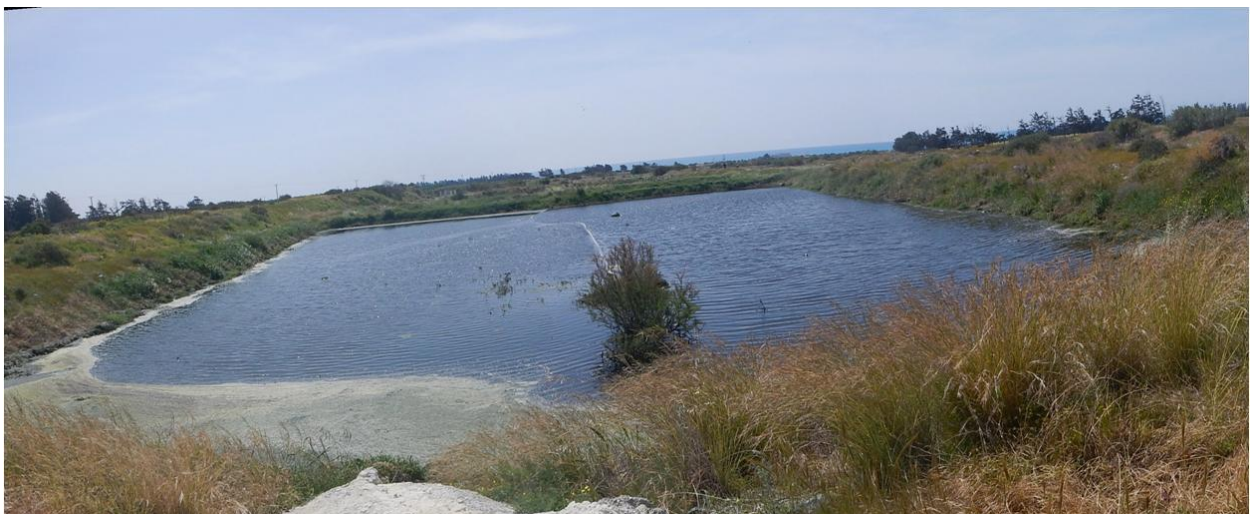
Φωτογραφία 4: Δεξαμενή rp_9-6-9_A2a από κατάντη
