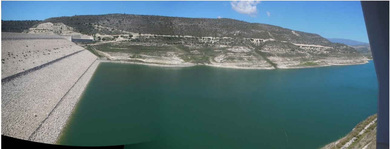
Φωτογραφία 17: Φράγμα Κούρη-Αποψη δεξιάς πλευράς ταμιευτήρα
