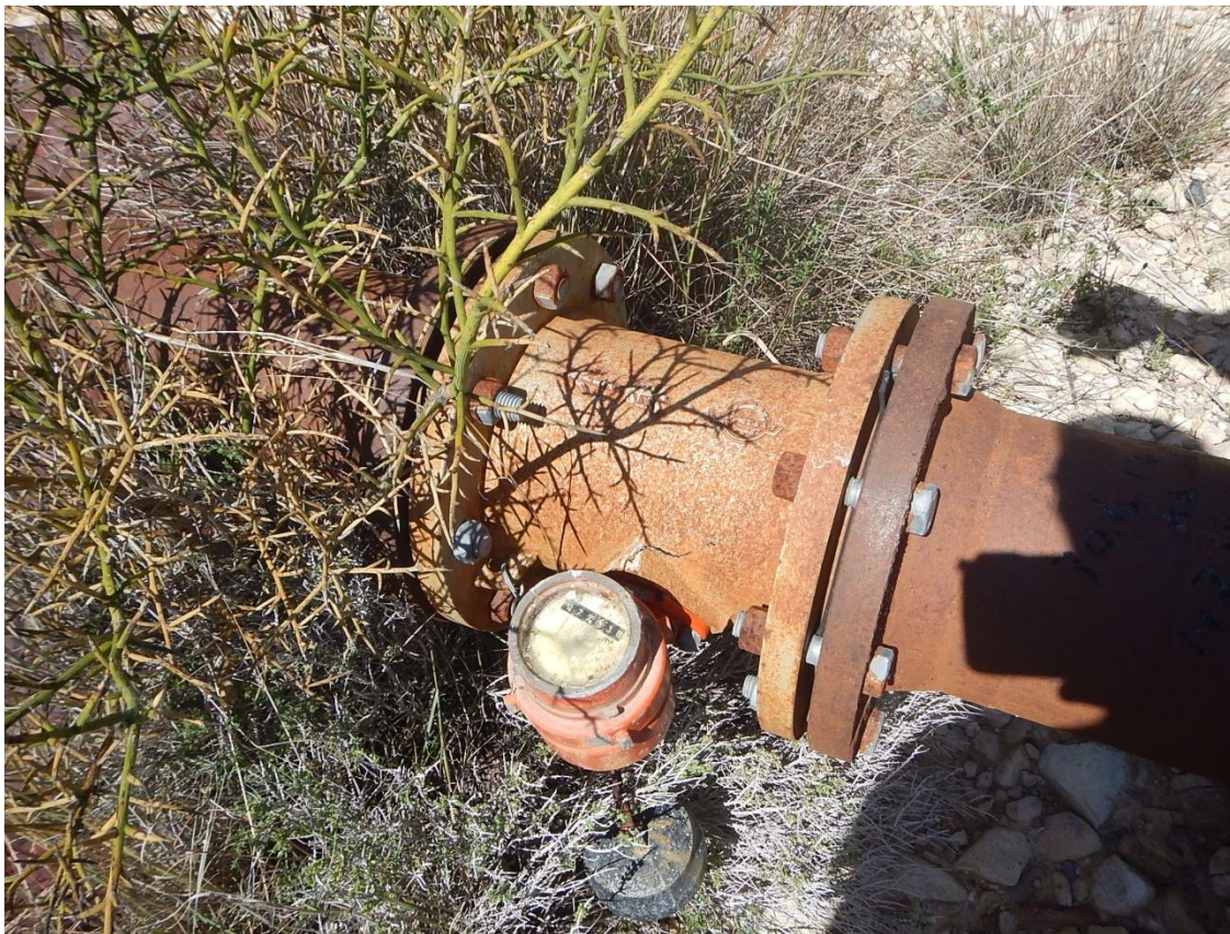
Φωτογραφία 18: Διάταξη μέτρησης απωλειών από το δεξι αντέρεισμα
