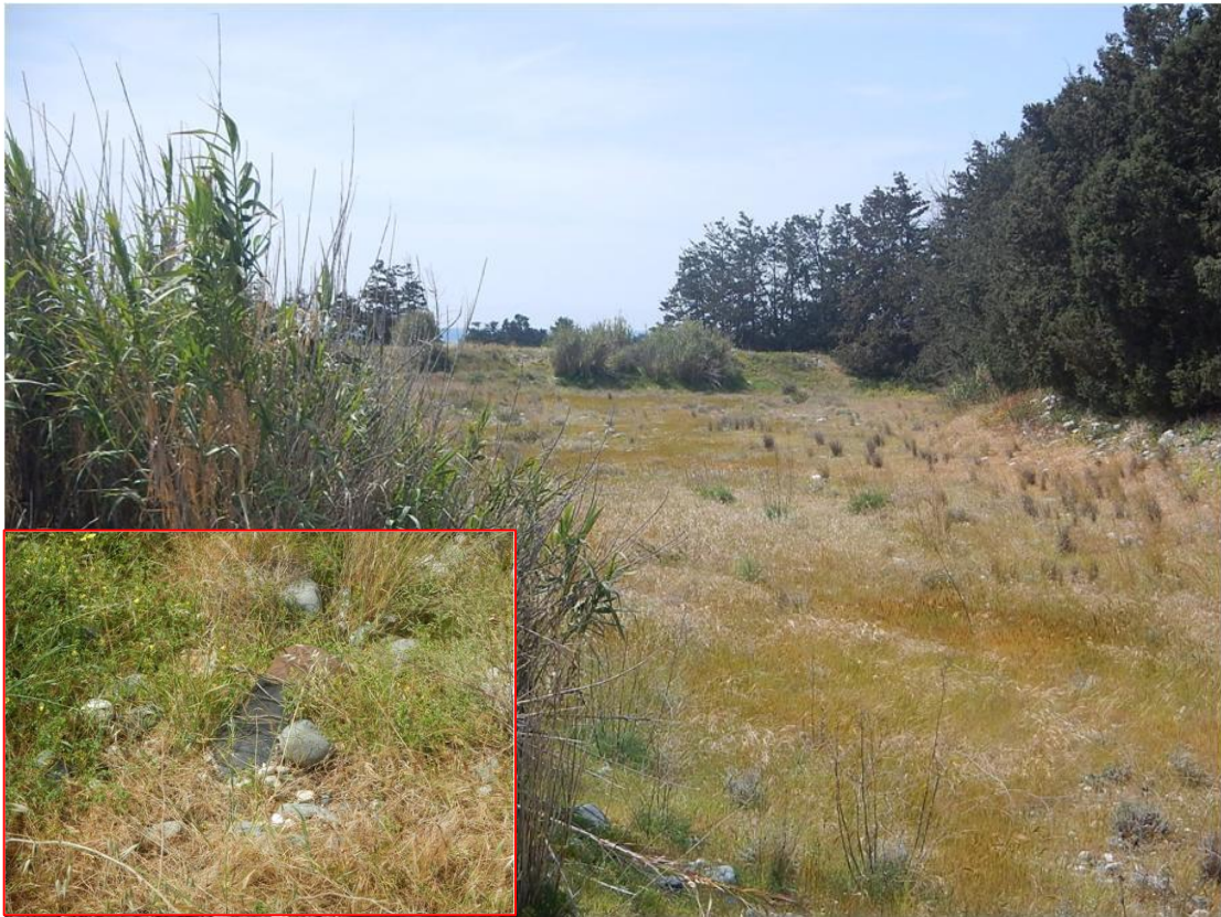
Φωτογραφία 3: Δεξαμενή rp_9-6-9_A1a και εγκαταλελειμένος αγωγός τροφοδοσίας της
