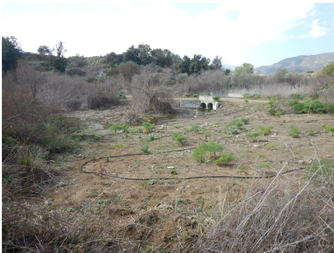
Εικόνα 3: Άποψη ποταμού κατάντη αγροτικού δρόμου, πριν και μετά τα έργα υδρομορφολογικής αποκατάστασης- Τμήμα 1 (Φώτο: I.A.CO Ltd).
