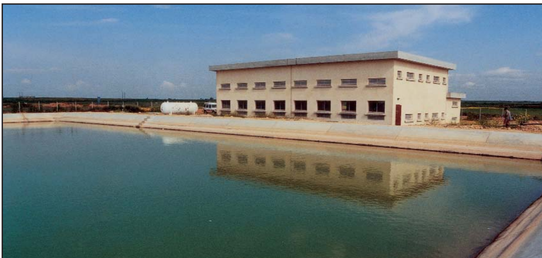
Αντλιοστάσιο στην περιοχή Κοκκινοχωριών
