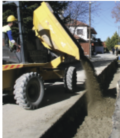
Τοποθέτηση υλικού επιχωμάτωσης
