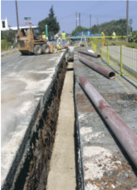
Τοποθέτηση υλικού έδρασης σωλήνα
