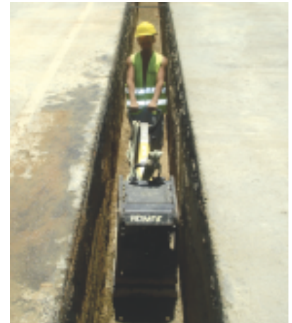
Συμπύεση υλικού επιχωμάτωσης
