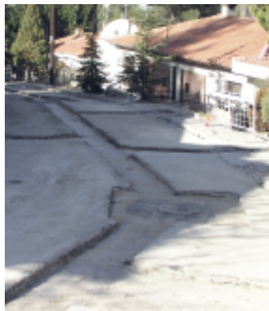
Τοποθέτηση θεμελίου οδοστρώματος
