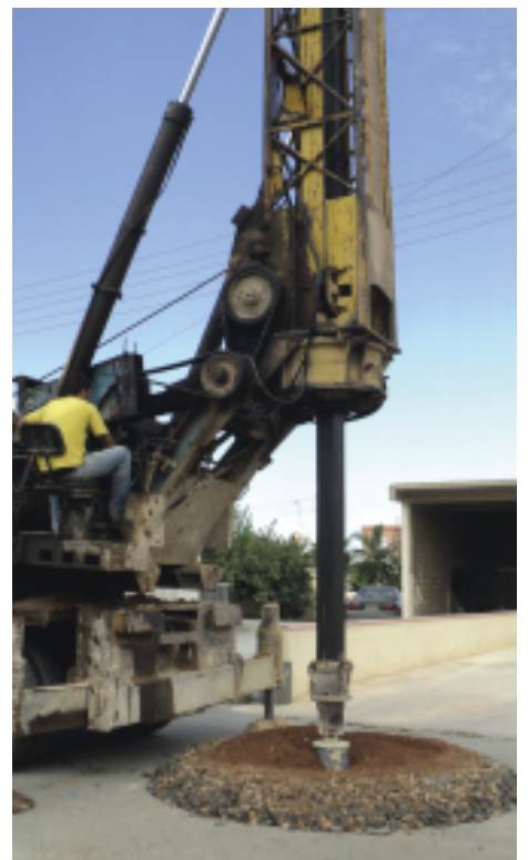
Διάτρηση φρεατίου
