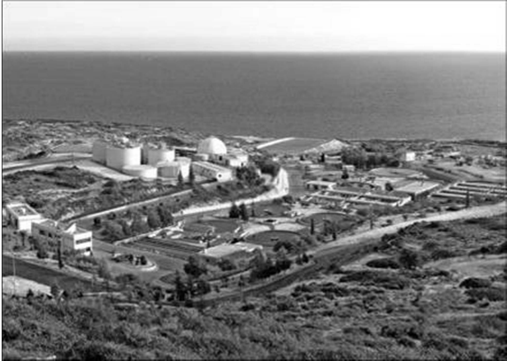
• LIMASSOL (MONI) WWTP
